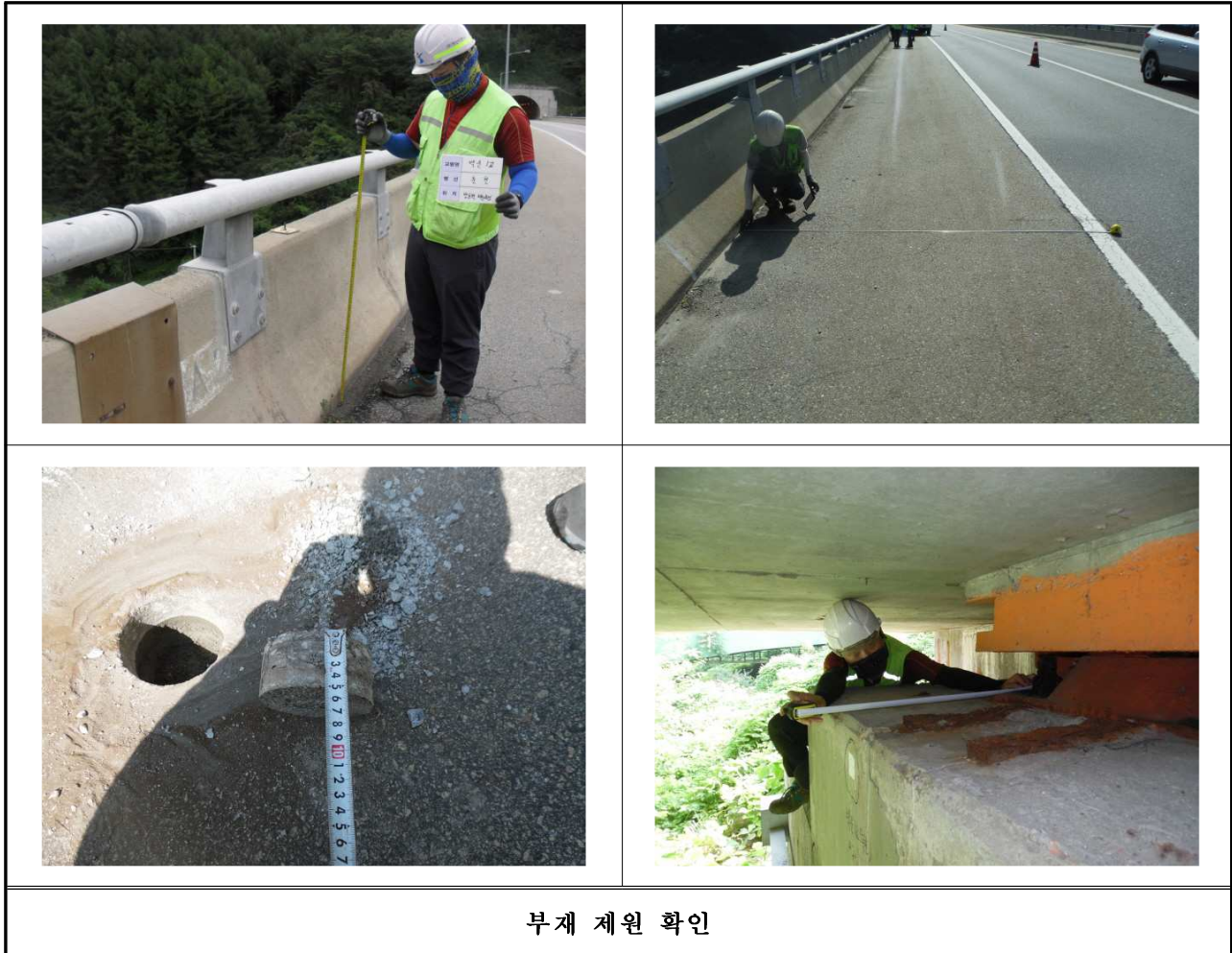
【사진 5.2】 백운1교(춘천) 부재 재원 측정
